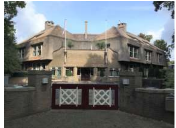
Rondelaan 30 Bosschool Architect: Theo Lammers (1890-1972) Bouwjaar: 1925 Amsterdamse School
