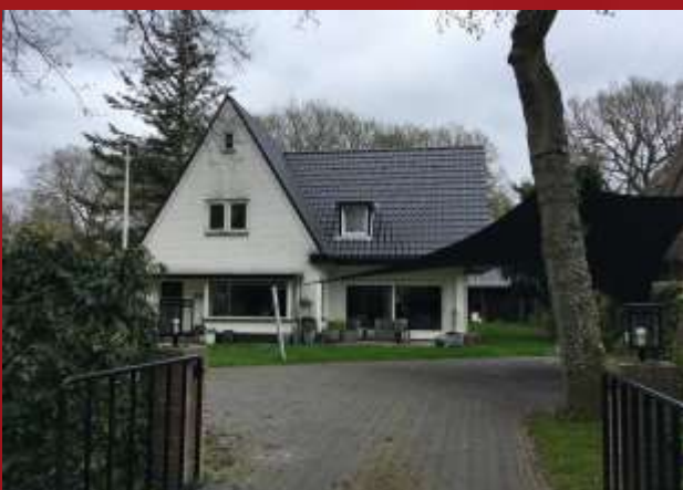
MEERWEG 1 (ARCHITECT ONBEKEND) BOUWJAAR 2012
