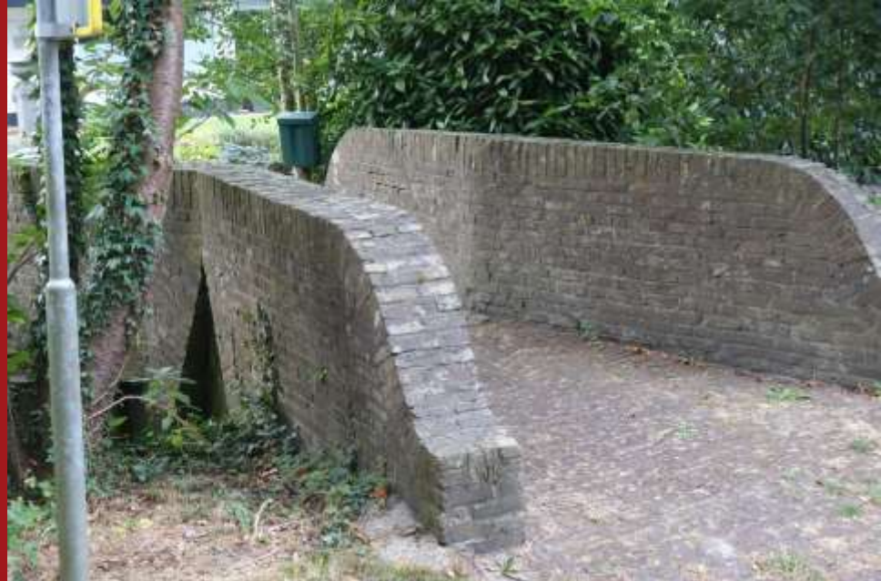
Het metselwerk, waarvan de hoeken van de borstweringen golvend zijn, loopt door tot aan het water. De doorstrooomopening voor het water is driehoekig vormgegeven.
