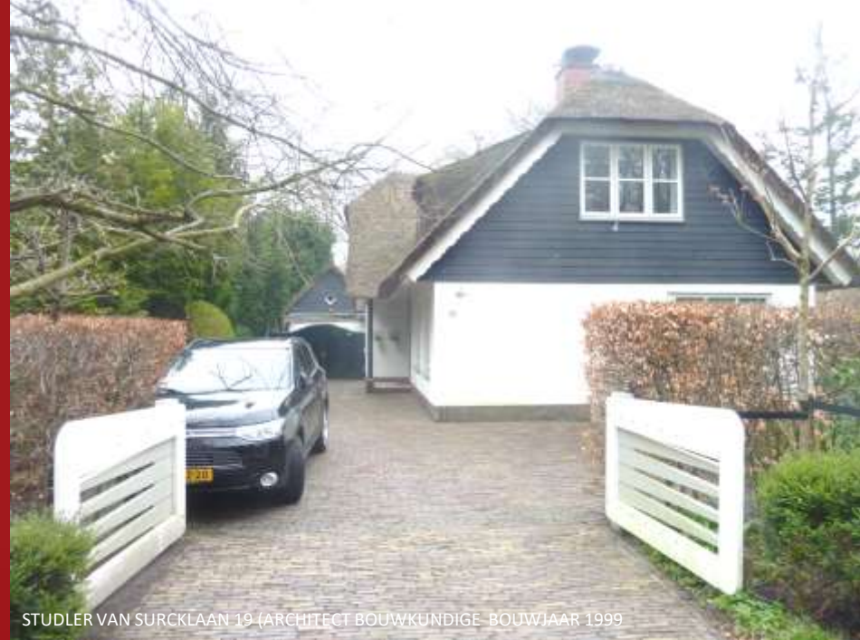
STUDLER VAN SURCKLAAN 15-S (ARCHITECT ONBEKEND) BOUWJAAR 19..
