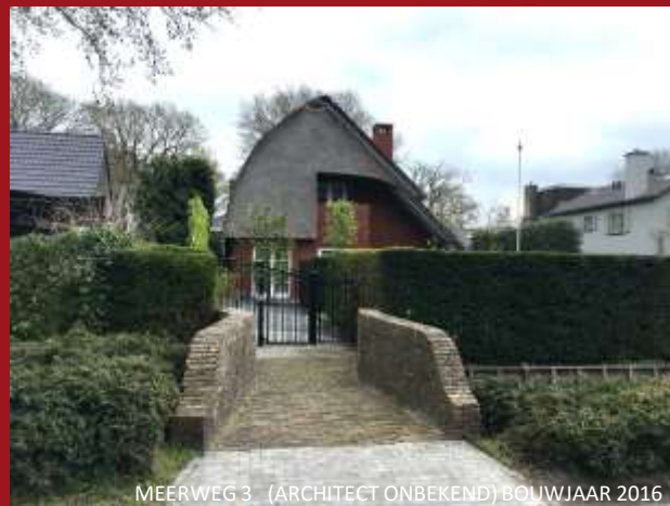
MEERWEG 3 (ARCHITECT ONBEKEND) BOUWJAAR 2016
