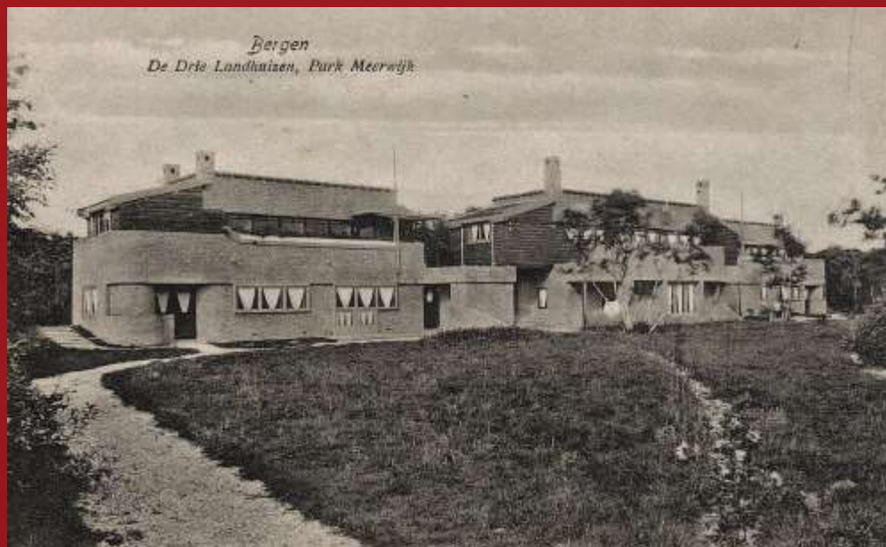
OVERZICHTSFOTO VAN HET COMPLEX NA DE BOUW
