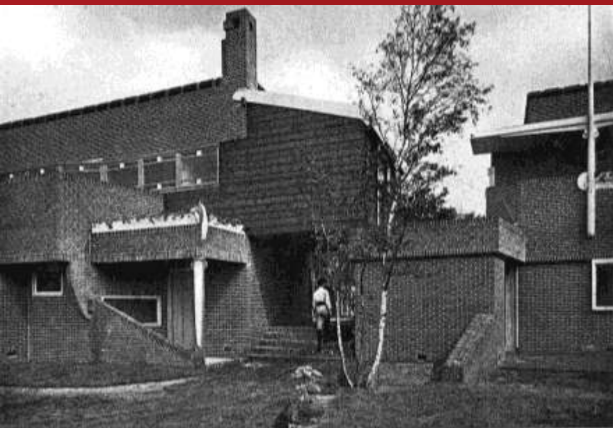
DETAILFOTO VAN DE OOSTELIJKE SCHAKEL
