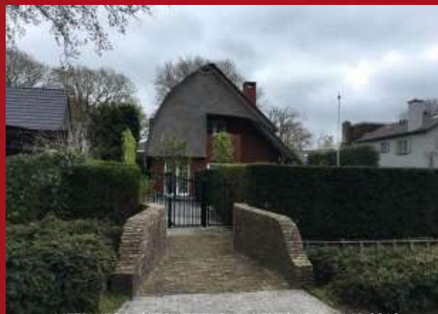
MEERWEG 3 (ARCHITECT ONBEKEND) BOUWJAAR 2016
