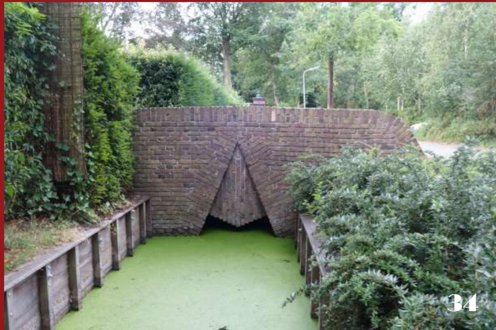
Het metselwerk, waarvan de hoeken van de borstweringen golvend zijn, loopt door tot aan het water. De doorstrooomopening voor het water is driehoekig vormgegeven.
