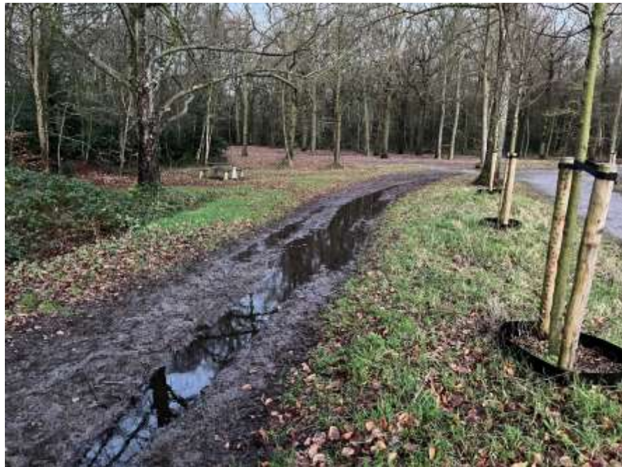
VERZAKKING PAARDENPAD VIJVERLAAN
